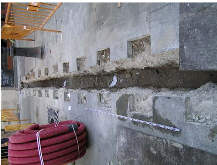
5. Detall de la rasa realitzada al número 29 un cop realitzat el buidatge de terres
